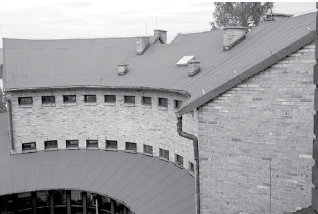
Wyremontowany dach nad salkami
